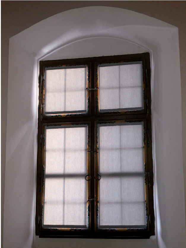
10 Landshut, Burg Trausnitz, Säle der Wirkteppiche. Trotz starker Abdunkelung bleibt die Fenstergliederung noch ablesbar, auf der Tapiserie werden in Fensternähe auch bei direkter Sonneneinstrahlung keine 50 Lux erreicht. Eine Vollverdunkelung mit einem Black-Out-Stoff oder einer Kartonplatte wirkt dagegen im Denkmalkontext oft unangebracht.
