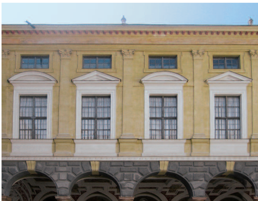
3 Stadtresidenz Landshut, Fassadenansicht Innenhof. Seit den 1990er Jahren bestand der standardmäßig verbaute Lichtschutz aus zusätzlichen Vorhängen mit einseitig metallbedampftem Gewebe. Obere Fensterreihe ohne Lichtschutzelemente, die Scheiben erscheinen dunkel.
