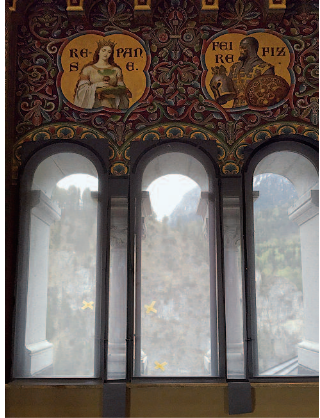
11 Schloss Neuschwanstein, Palas, Sängersaal. Das montierte Screengewebe hat eine Transmission von 5 %, wegen des openness factors von 4 % ist die Durchsicht nach draußen trotzdem noch gut.
