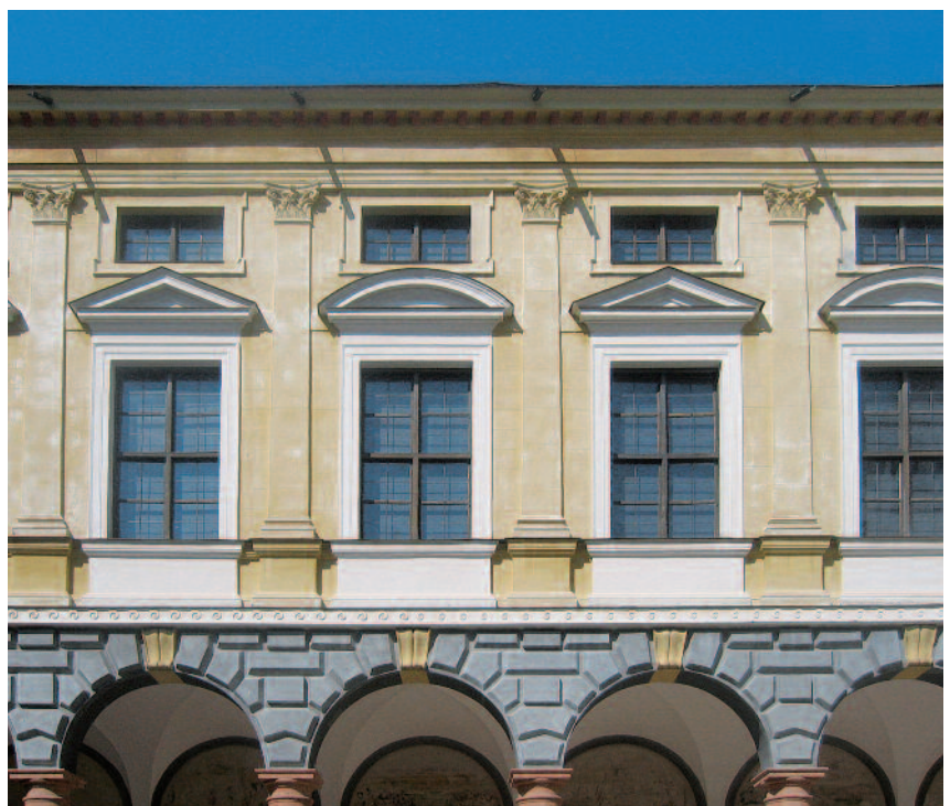
7 Stadtresidenz Landshut, Fassadenansicht Innenhof, Fenster mit dunklem Lichtschutzscreen. Im Vergleich zu Abb. 3 wird der ästhetische Gewinn bei der Fassadenansicht deutlich.
