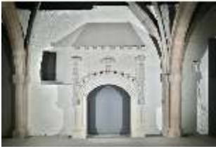
Ca.II, Kamin (rekonstr.), Erkersaal, 2016, DI023946, BSV-
