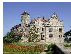
Ca.V, Blick von Süden auf die Hauptburg über den Burggarten, DI007070, BSV-
