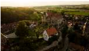
Ca.I, Luftaufnahme der Burg von Osten, DI025748, BSV-
