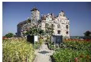
Ca.V, Blick von Süden auf die Hauptburg mit Informationstafeln, DI007061, BSV-
