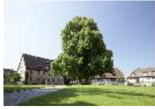
Ca.I, Vorburg, Gesamtanlage, DI011838, BSV
