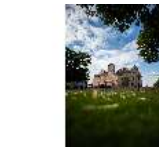
Ca.1, Blick auf die Burg von Süden, DI025833, BSV-
