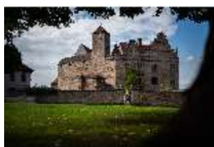
Ca.1, Blick auf die Burg von Süden, DI025834, BSV-
