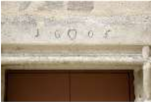
Ca.I, Mauerabschnitt mit Datierung 1605, DI000188, BSV
