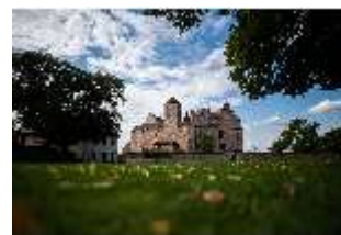
Ca.1, Blick auf die Burg von Süden, DI025832, BSV-
