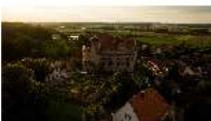
Ca.I, Luftaufnahme der Burg von Südosten, DI025744, BSV-
