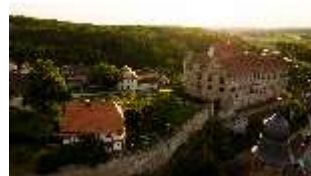
Ca.I, Luftaufnahme der Burg von Osten, DI025746, BSV-
