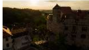
Ca.I, Luftaufnahme der Burg bei Abendlicht, DI025752, BSV-
