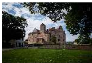
Ca.1, Blick auf die Burg von Süden, DI025830, BSV-
