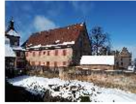
Ca.1, Altes Schulhaus von Süden-Osten, DI020549, BSV-
