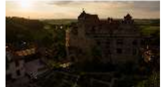
Ca.I, Luftaufnahme der Burg bei Abendlicht, DI025753, BSV-
