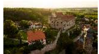
Ca.I, Luftaufnahme der Burg von Osten, DI025747, BSV-
