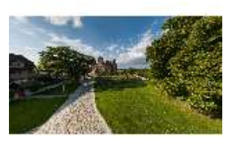
Ca.1, Blick auf die Burg von Süden, DI025725, BSV-
