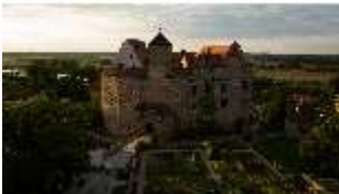
Ca.I, Luftaufnahme der Burg bei Abendlicht, DI025754, BSV-
