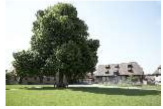
Ca.I, Vorburg, Gesamtanlage, DI011840, BSV
