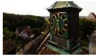
Ca.I, Luftaufnahme, Blick auf die Uhr am Torturm (Vorburg), DI025735, BSV-
