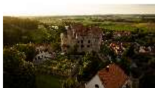
Ca.I, Luftaufnahme der Burg von Südosten, DI025745, BSV-
