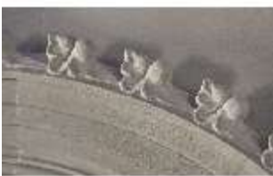
Ca.VII, Erkersaal, rekonstruierter Kamin, Detail, DI010638, BSV-
