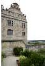
Ca.I, Blick von Süden, Detail, DI000203, BSV
