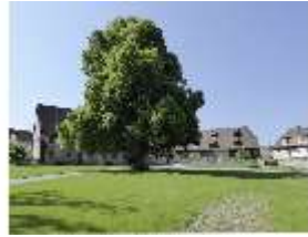
Ca.I, Vorburg, Gesamtanlage, DI011842, BSV
