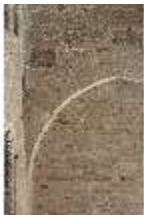
Ca.II, Zugemauerter Türbogen, DI010630, BSV-
