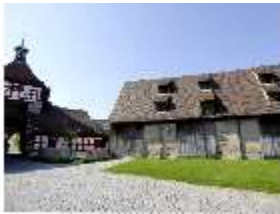
Ca.I, Vorburg, Gesamtanlage, DI011845, BSV
