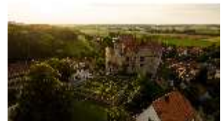
Ca.I, Luftaufnahme der Burg von Südosten, DI025743, BSV-
