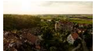
Ca.I, Luftaufnahme der Burg von Südosten, DI025750, BSV-
