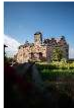
Ca.1, Blick auf die Burg von Süden, DI025848, BSV-
