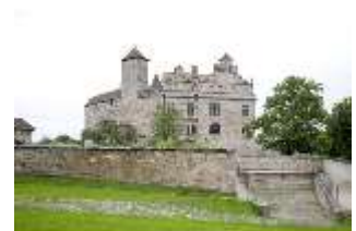
Ca.1, Blick von Süden, DI000796, BSV
