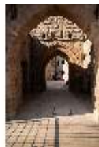
Ca.I, Hauptburg, Torbau, DI025851, BSV-
