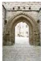
Ca.I, Torbau von innen, DI000207, BSV
