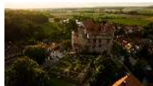
Ca.I, Luftaufnahme der Burg von Südosten, DI025742, BSV-
