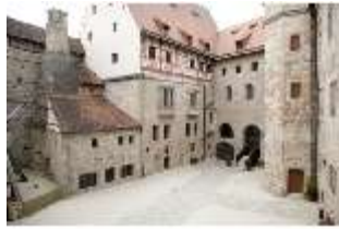
Ca.I, Innenhof von Westen, DI000194, BSV
