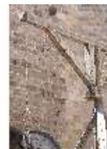
Ca.I, Tretkran im Innenhof der Cadolzburg, Detail, DI010631, BSV-
