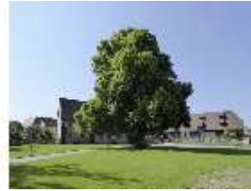
Ca.I, Vorburg, Gesamtanlage, DI011843, BSV
